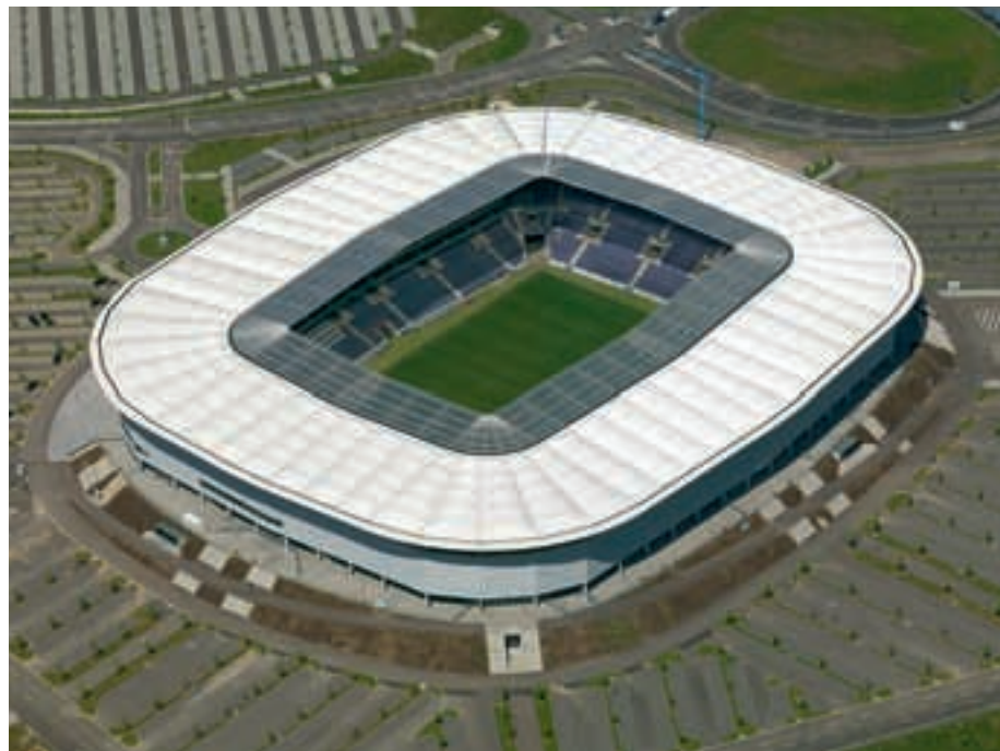
Tôles fortes de Dilling pour la structure en acier du toit du stade Rhein-Neckar-Arena à Sinsheim
