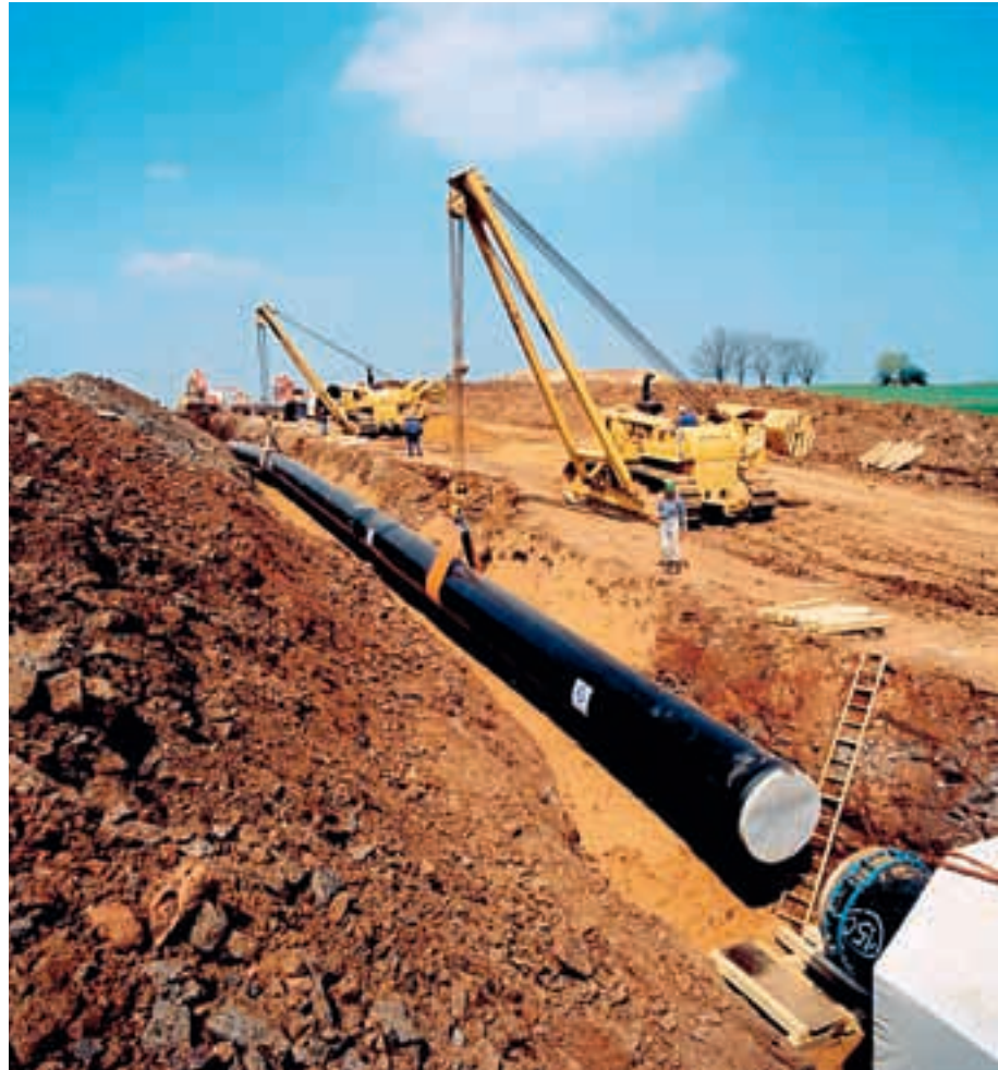
Pose terrestre des gros tubes d'EUROPIPE
