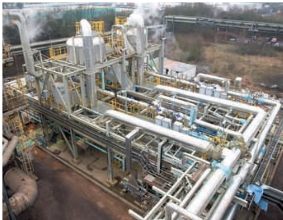
Rénovation de ZKS – Optimisation de la production et protection de l'environnement (ici : la nouvelle batterie B3 et l'installation Claus)
