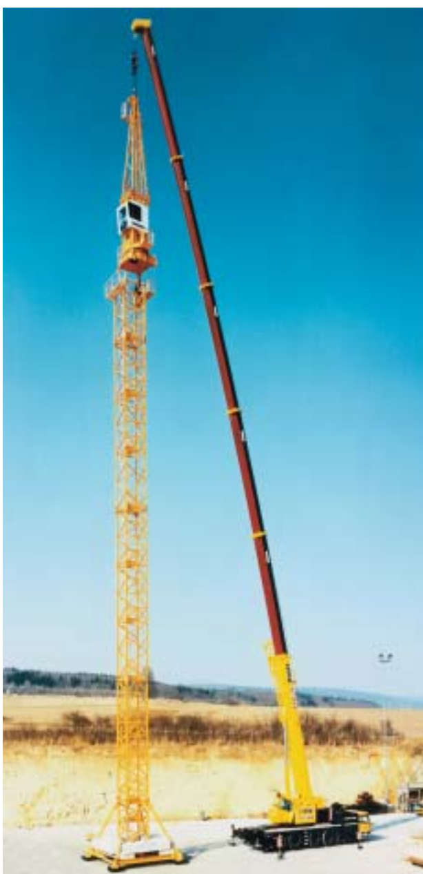
Figure 20 : Grue mobile lors du montage d'une grue de chantier (photo publiée avec l'aimable autorisation de Liebherr-Werk Ehingen GmbH, Ehingen)
