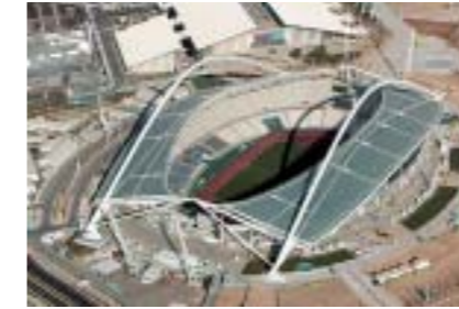
Source: Costruzioni Cimolai Armando spa
