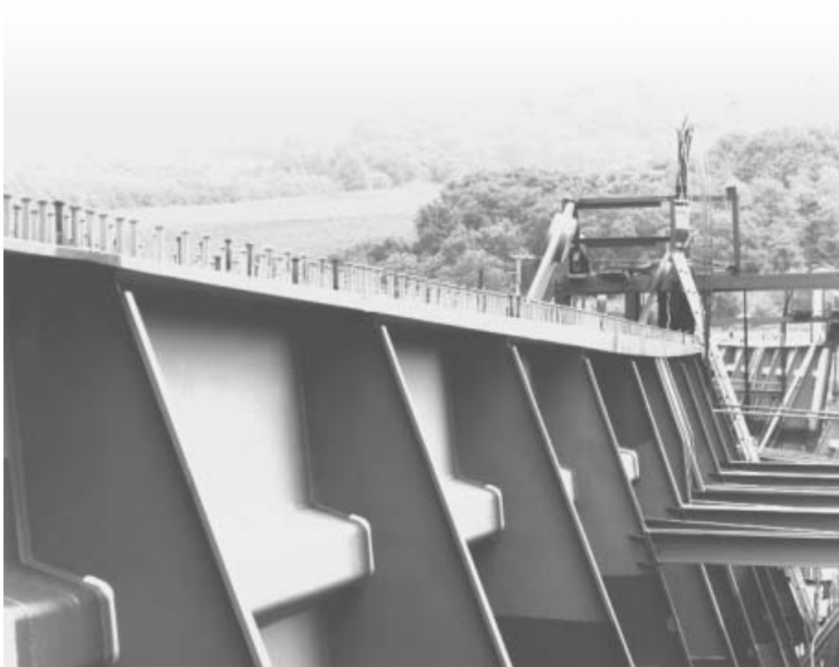
Obergurt der Moselbrücke Schengen, Luxemburg: 1.100 t LP-Bleche S355N bis 140 mm Dicke
