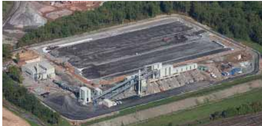
Effiziente Schlackenwirtschaft: Die neue Mineralstoffaufbereitungsanlage
