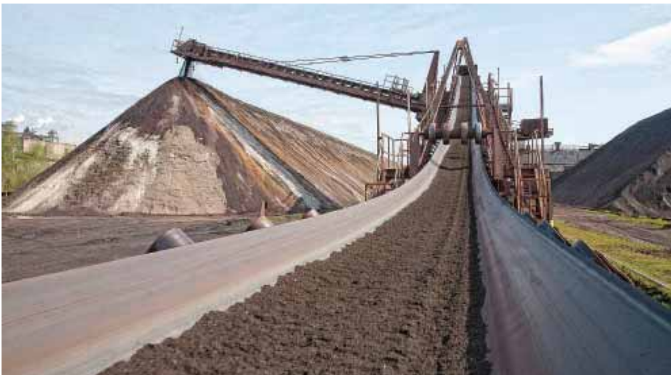
Rohstoff-Transport auf dem Hüttengelände – Blick auf die Mischbetten der ROGESA
