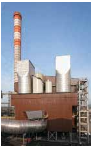
Weitere Verbesserung der Emissions- situation am Standort Dillingen: die Prozessabgasnachbehandlungs- anlagen der ROGESA
