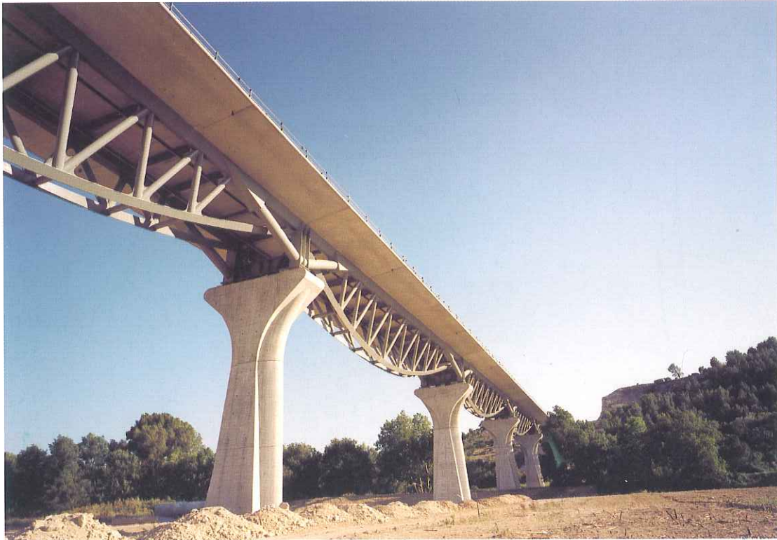
Viaduc en arêtes de poisson de l'Arc
