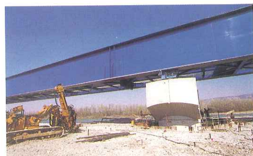
Ossature métallique du tablier
